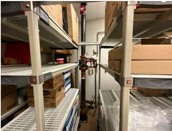
33 - FIRE SPRINKLER RISERS
