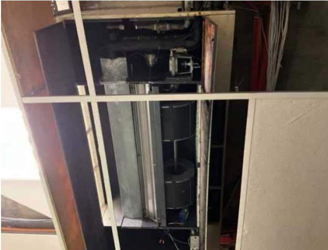
25 - TYP. UNIT VENTILATOR
