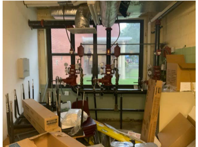
14 - FIRE SPRINKLER RISERS
