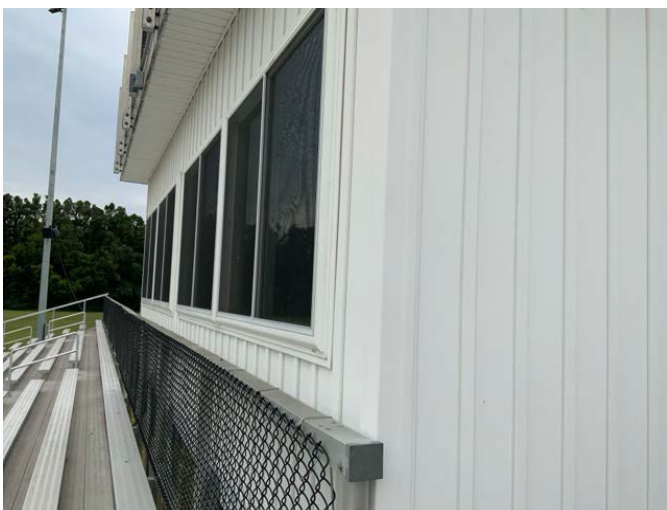
5 - EXTERIOR WALLS - PRESS BOX
