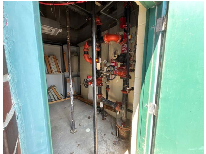
32 - FIRE SPRINKLER RISERS
