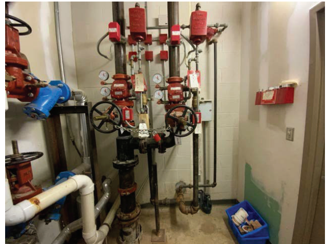
28 - FIRE SPRINKLER RISERS
